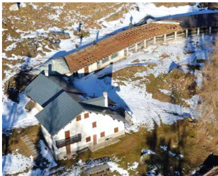
Sistemazione della copertura danneggiata della struttura adibita a ricovero bestiame presso Malga Agnè di Fuori.
