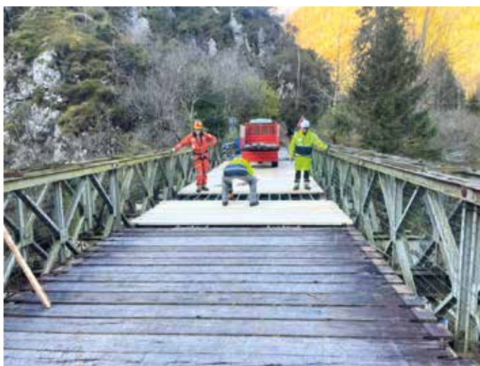
Alpini e protezione civili impegnati nel ripristino del ponte del Gigión.
