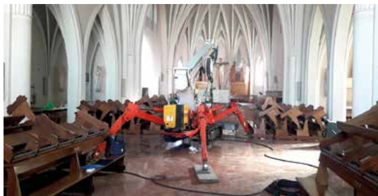
Un momento della messa a norma dell'impianto elettrico della chiesa di Frassenè, nel 2019 anche questo sovvenzionato.
