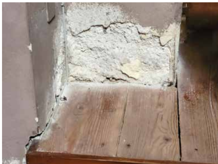
Una delle zone dove si notano maggiormente i segni di deterioramento degli intonaci è il presbiterio: qui un'immagine nei pressi dell'ingresso in sacrestia (foto sopra) e guardando l'altare sulla colonna di sinistra (foto sotto).
