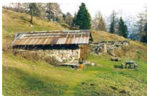
Casera prima del restauro.
