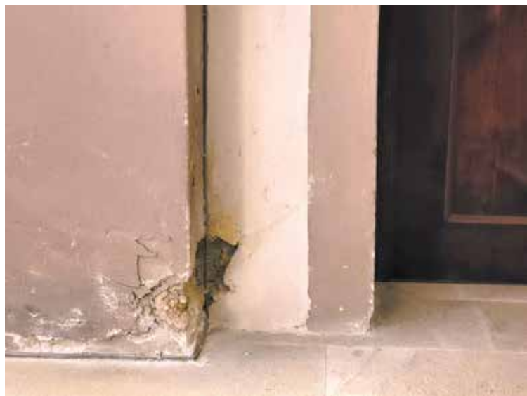
Una delle zone dove si notano maggiormente i segni di deterioramento degli intonaci è il presbiterio: qui un'immagine nei pressi dell'ingresso in sacrestia (foto sopra) e guardando l'altare sulla colonna di sinistra (foto sotto).
